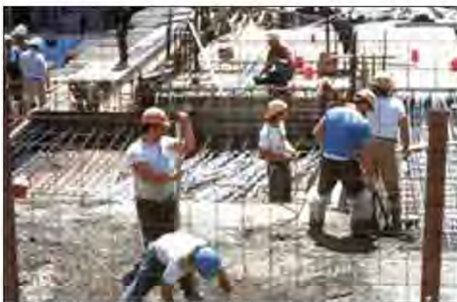
Foto repertorio di un cantiere edile a pieno regime.
